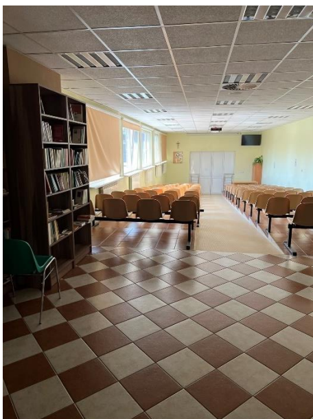
Zdjęcie nr 14: Zbyt niski sufit, brak informacji dla osób wysokich
